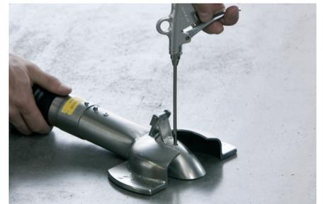
Ausblasen des Bohrlochs mittels Luftpistole mit Rohrverlängerung
